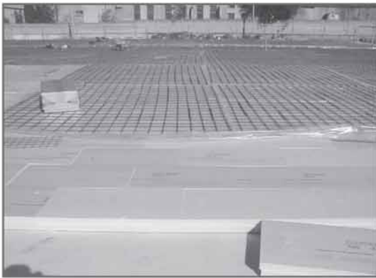
Lämpöeristys ja perustuksen raudoitus
