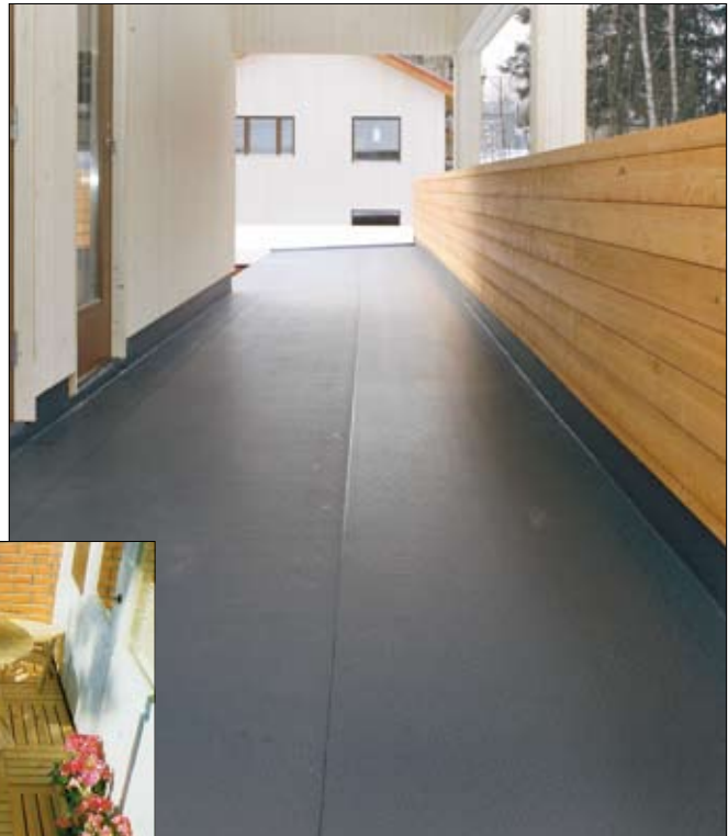
Protan SE asennettuna terassille
