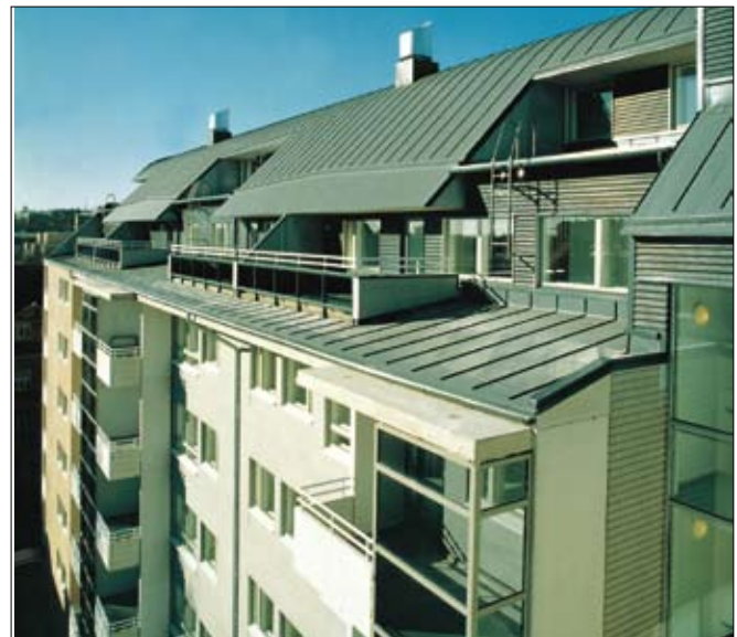
Omegaprofiilein rakennettu uudiskohde, Turku, 1000 m 2
