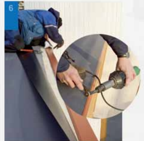
6. Räystäälle asennetaan tippapelti, johon Protan-vedeneriste hitsataan kiinni.
