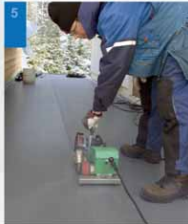
5. Seuraava vedeneriste limitetään edellisen kanssa ja hitsataan yhteen käyttämällä puoliautomaattista kuumailmalaitetta. Näin saadaan aikaan yhtenäinen sauma.
