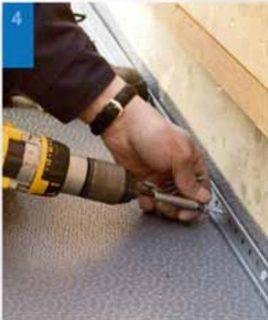
4. Seinään kiinnittäminen tapahtuu teräskiskolla ja ruuvilla.
