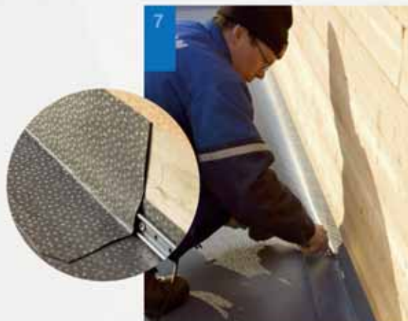
7. Seinänosto tehdään enillisestä kappaleesta. Vedeneriste nostetaan seinälle n. 300 mm ja saumahitsataan kiinni lattiaan.
